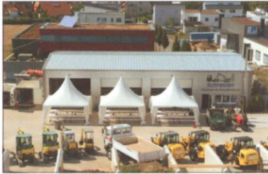
Blick auf die neue Halle und den Fuhrpark.
